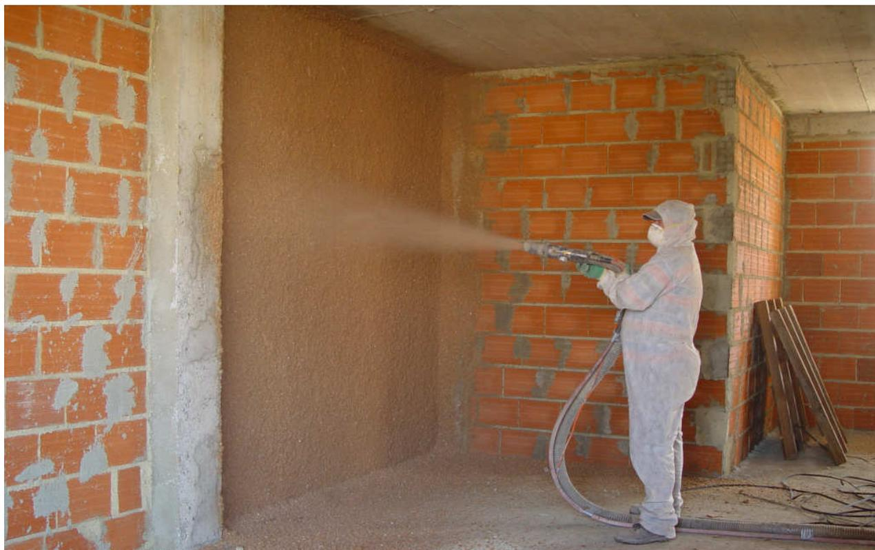
Parede de alvenaria projectada pelo interior com CELBAR®
